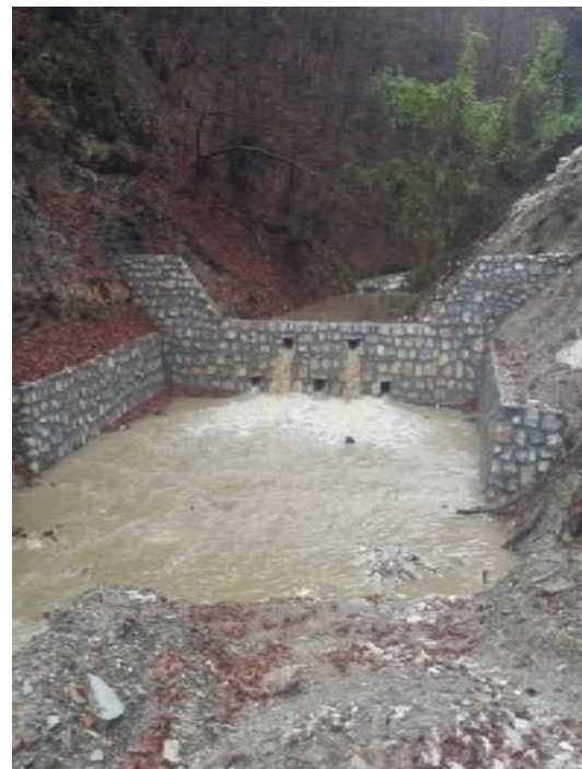
Слика 10. Изградња брана на 5 притока реке Рашке
