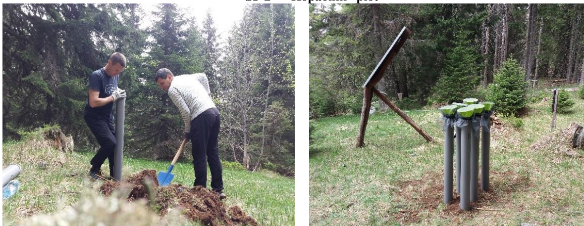
Слика 14.7-14.8. Постављање „Bulk“ колектора за влажну депозицију на отвореној површини Figure 14.7-14.8. Installation of "Bulk" collectors for wet deposition in the open field
